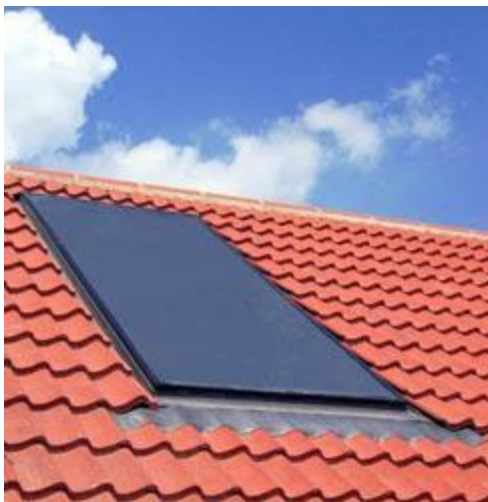
Afb. 6.2 Vlakke plaat in dak
