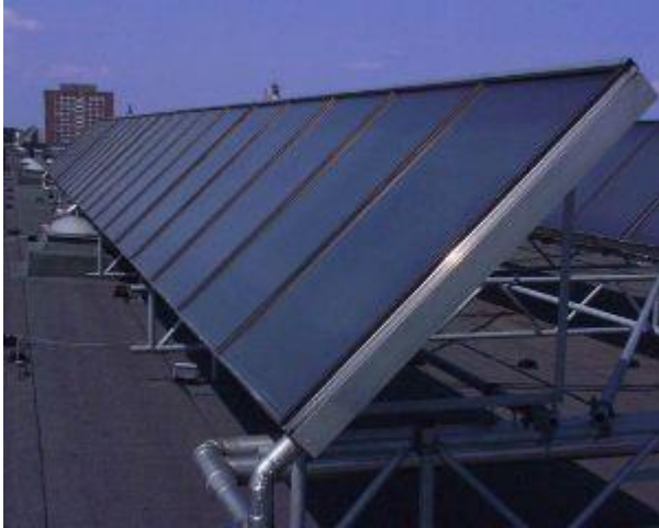
Afb. 6.6 Frames vast bevestigd
