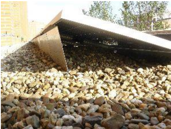
Afb. 7.2 Gebruik van het grind van het dak als ballast in de montagebak
