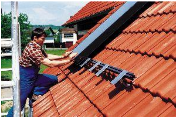
Afb. 6.1 Bevestiging vlakkeplaatcollector op dak m.b.v. dakframe
