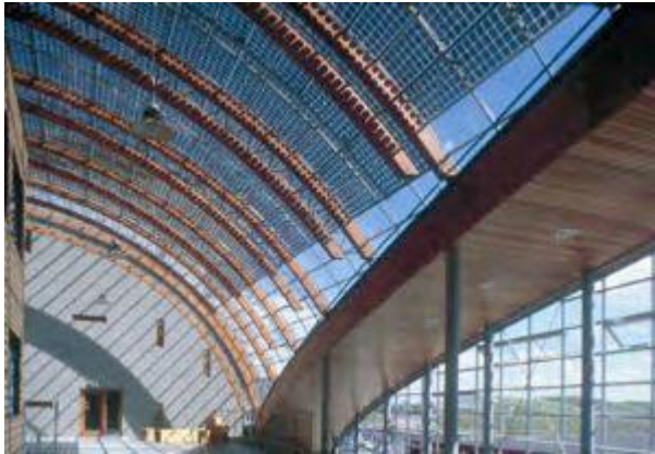
Afb. 7.4 PV-installatie bij ECN in Petten
