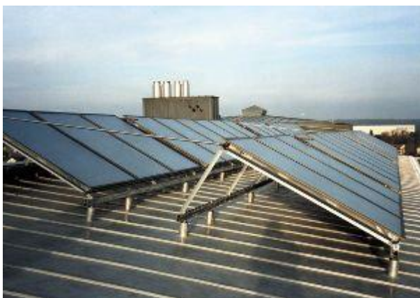
Afb. 6.4 Frames vast bevestigd
