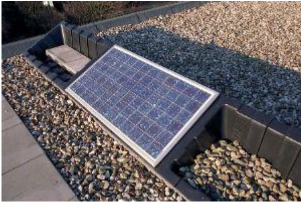
Afb. 7.1 Frame met ballast
