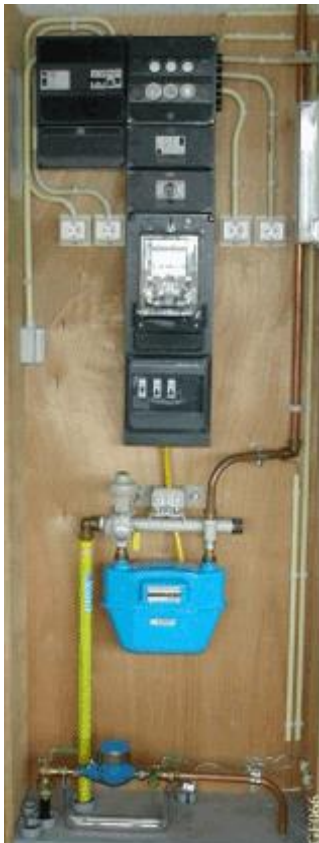
Afb. 1.7 Voorbeeld indeling en maatvoering meterkast van een laagbouwwoning volgens NEN 2768
