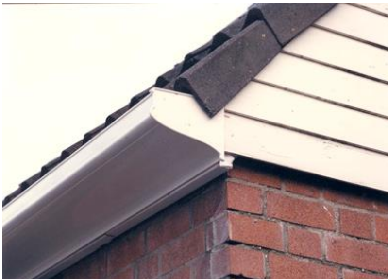
Afb. 10.7 Bij goten die 'waterpas' zijn gemonteerd heeft men onder invloed van normale bouwtoleranties 50% kans dat de goot in werkelijkheid op tegenschot ligt
