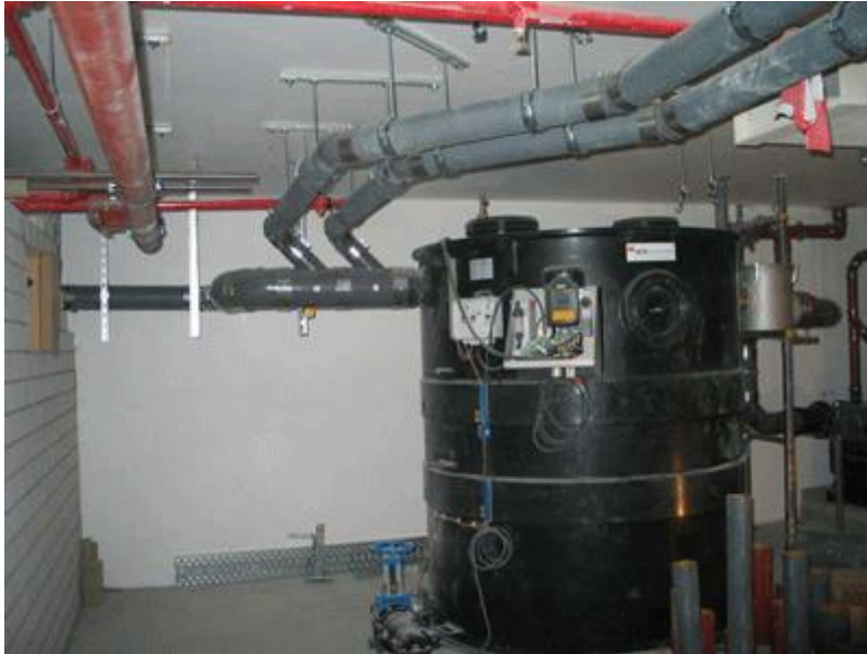
Afb. 6.3 Vetafscheider voor binnenopstelling
