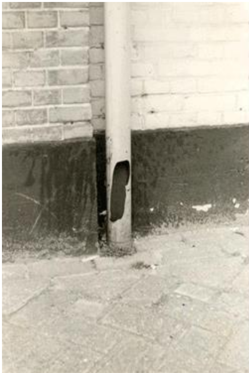
Afb. 12.1 Hemelwaterafvoer aan gevel zonder en met slagvast ondereinde
