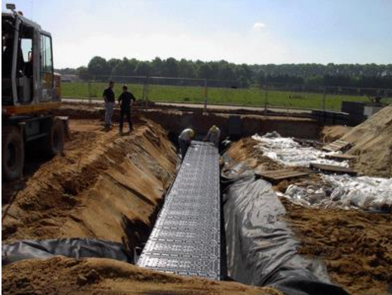
Afb. 10.11 Aanleg infiltratieboxen met geotextiel
