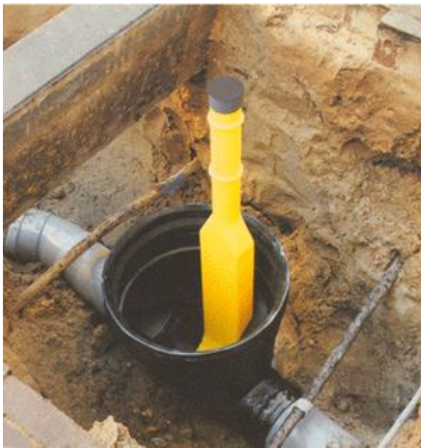
Afb. 6.1 Put voor het trekken van een afvalwatermonster
