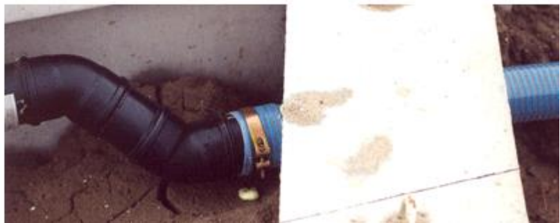
Afb. 4.38 Flexibele verbindingsslang door funderingsbalk
