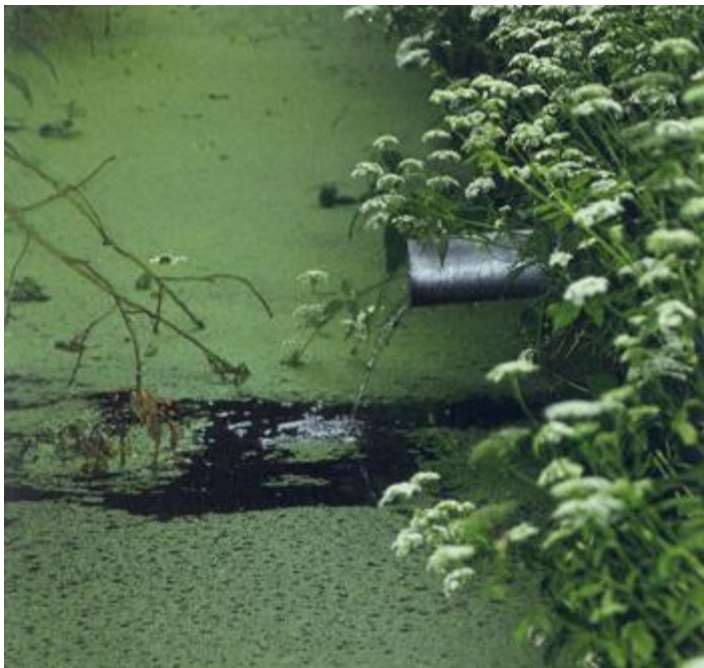
Afb. 10.12 Lozing van hemelwater op oppervlaktewater
