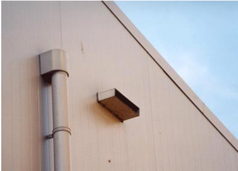
Afb. 13.3 Dakrandafvoer naast noodafvoer
