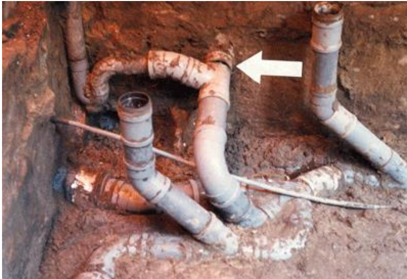
Afb. D.1 Klachten over rioolstank zijn vaak terug te voeren op grensvlakken van systeemovergangen
