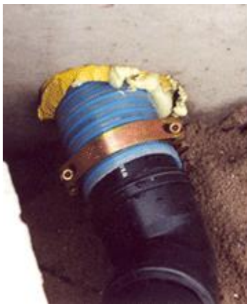
Afb. 4.38 Flexibele verbindingsslang door funderingsbalk
