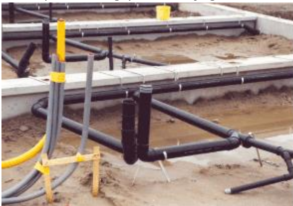
Afb. 4.35 Aanleg riolering in fundering.
