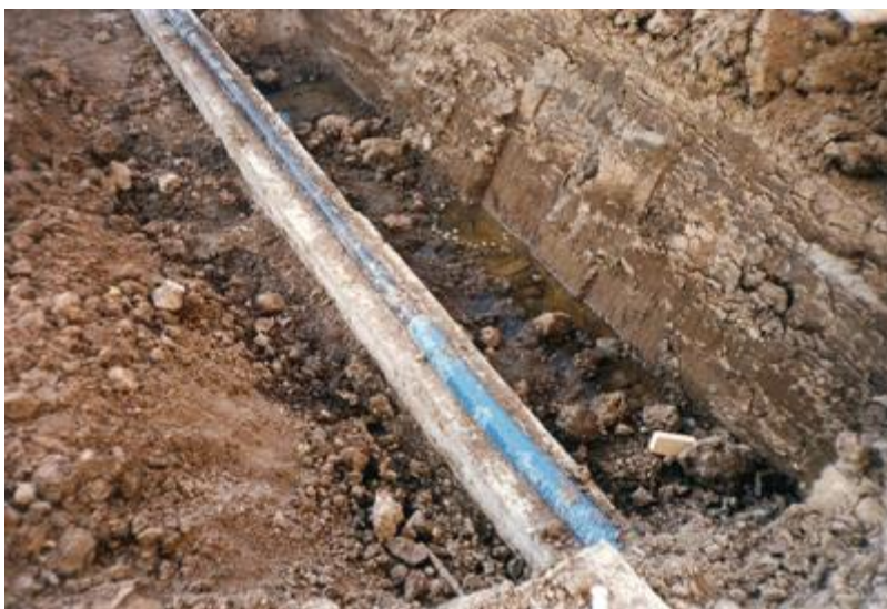
Afb. 4.39 Fundatie voor de buitenriolering (huisaansluitleiding)
