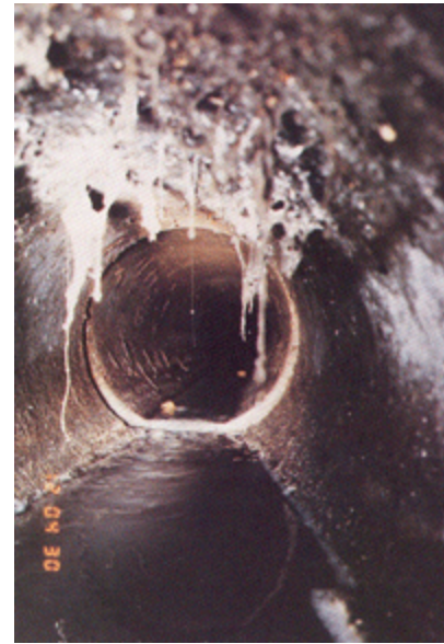
lokale horizontale verplaatsing
