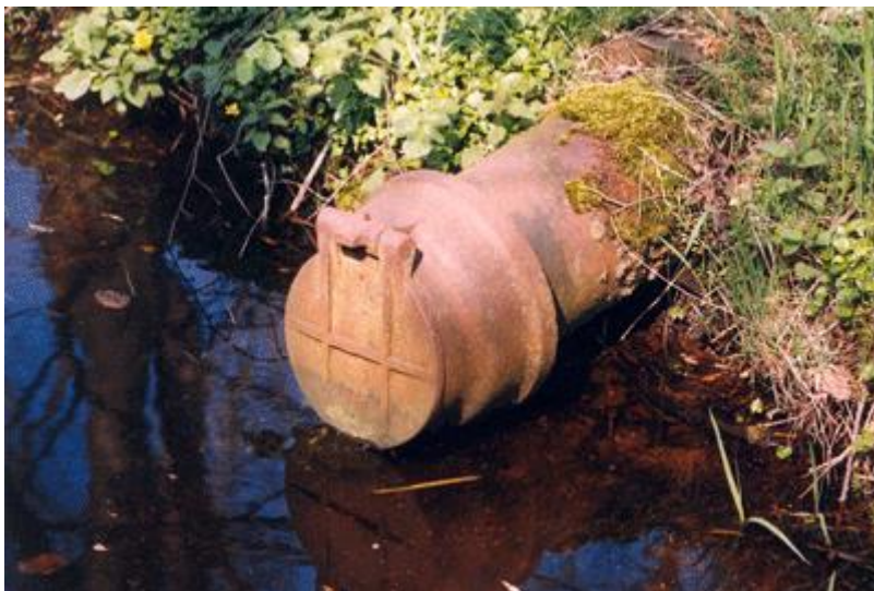
Afb. 13.1 Uitlaat van overstortvoorziening riool op oppervlaktewater
