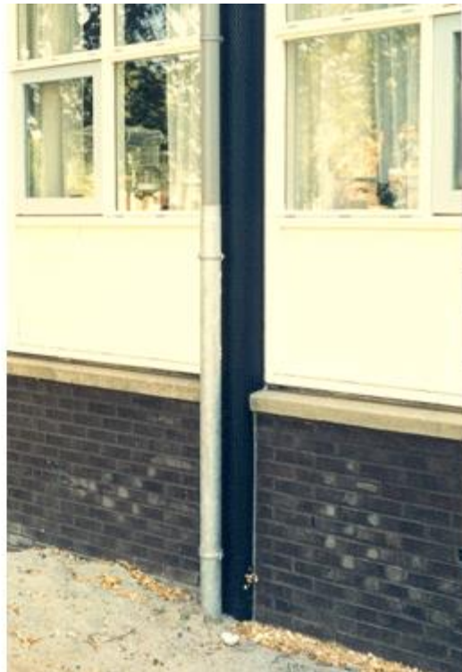
Afb. 12.1 Hemelwaterafvoer aan gevel zonder en met slagvast ondereinde
